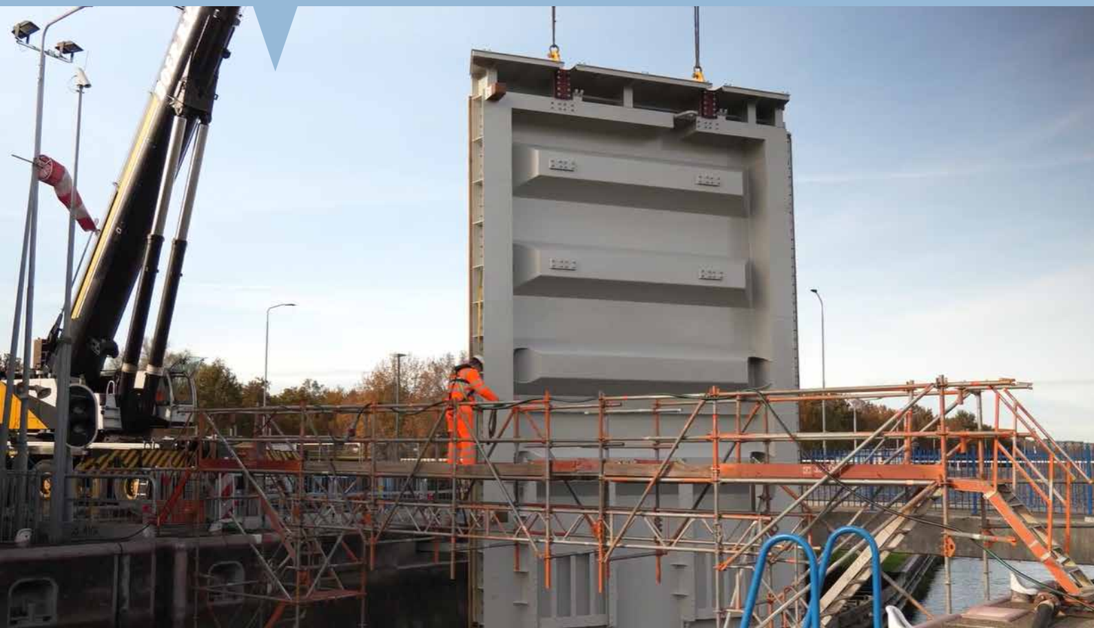
Foto 1: Plaatsen van nieuwe deuren in sluiscomplex Helmond
