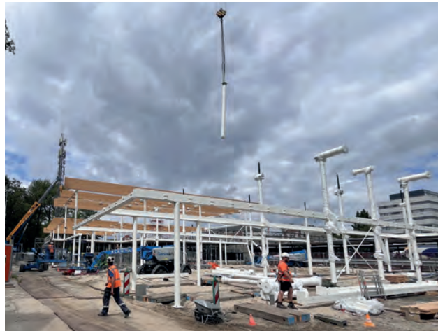
Bovenste twee: De staalconstructie in aanbouw.
